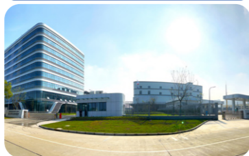
氢能与燃料电池检测基地
